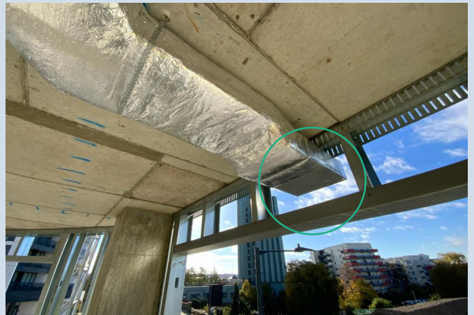
A1 Non Combustible Ducting
